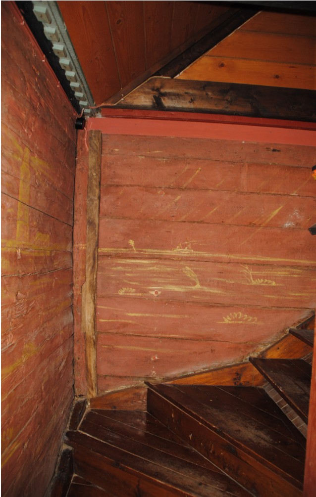
Efter att åtgärden är utförd och brädan som upptill döljer vinkeljärnet är inmålad.
